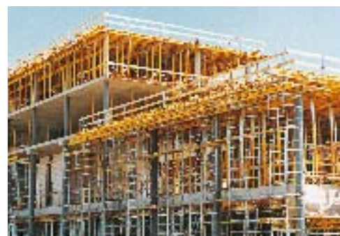
Nosíkové stropní bednění MULTIFLEX
