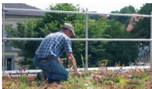
Bezpečnostní systém Optisafe „okrajové zábradlí“
