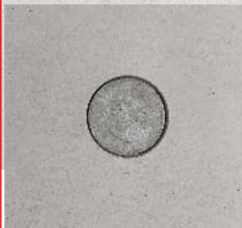
Otvor uzavřený běžným betonovým kónusem
