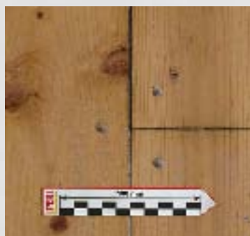
Příklad uchycení hřebíky
