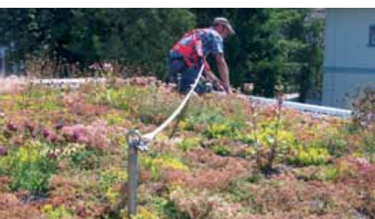
Bezpečnostní systém Optisafe „bodový pro šterkové plochy“
