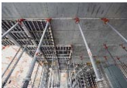
Panelové stropní bednění SKYDECK
