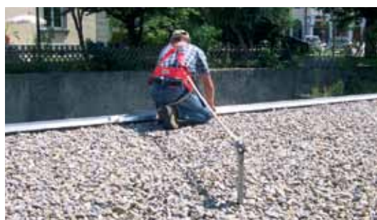
Bezpečnostní systém Optisafe „bodový pro šterkové plochy“
